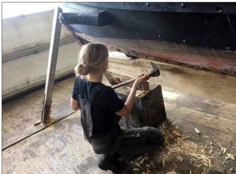
Fintilpasning med skarøkse
