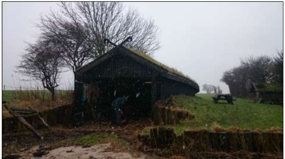
Arbejdet skrider godt frem i snevejret i ly af Naustens tag
